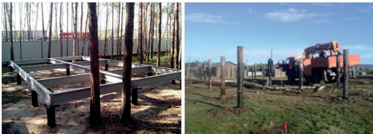
Рисунок 14. Винтовой свайный фундамент на примере частного дома и больницы на 10 коек в с. Нерюктяй Олекминского улуса
